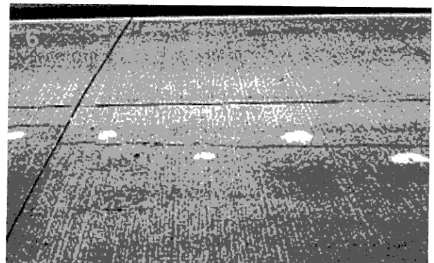
Hình 6 – Thi công sửa chữa vết nứt dọc theo phương pháp khoan đặt thanh liên kết xiên
