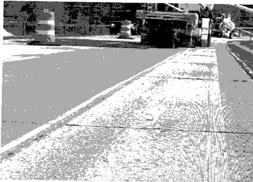
Hình 20 – Thi công theo phương pháp mài tạo rãnh
