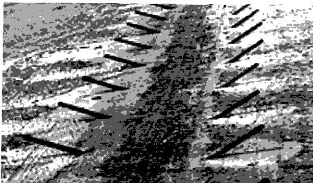
Hình 6 – Thi công sửa chữa vết nứt dọc theo phương pháp khoan đặt thanh liên kết xiên
